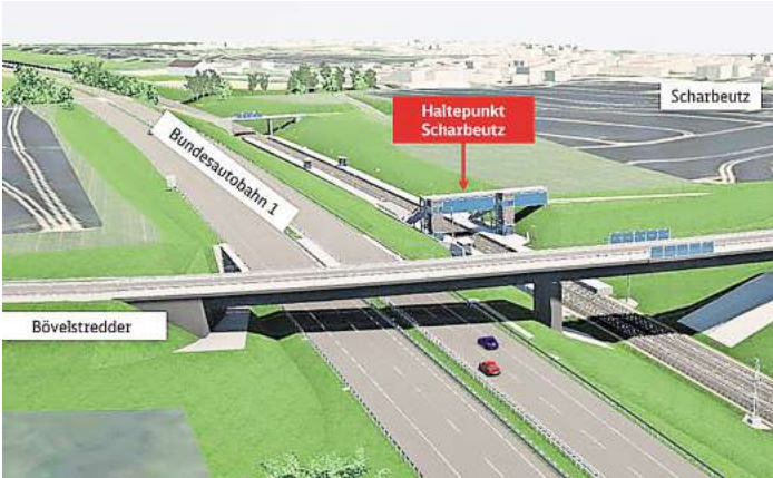
Der neue Bahnhof Scharbeutz. Es voraussichtlich der einzige Halt an der Hinterlandanbindung, der mit Aufzügen ausgestattet sein wird. Sonst werden Rampen für die Barrierefreiheit gebaut. Im Vordergrund: Die neuen Brücken über die A1 und Schienentrasse am Bövelstredder.
