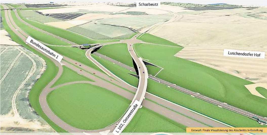
Drei Brücken und einen Kreisverkehr baut die Bahn an der neuen A1-Anschlussstelle Pansdorf für die Landesstraße nach Scharbeutz.
