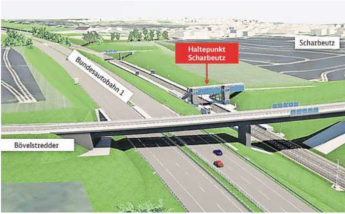
Der neue Bahnhof Scharbeutz. Es voraussichtlich der einzige Halt an der Hinterlandanbindung, der mit Aufzügen ausgestattet sein wird. Sonst werden Rampen für die Barrierefreiheit gebaut. Im Vordergrund: Die neuen Brücken über die A1 und Schienentrasse am Bövelstredder.
