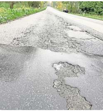
Die L309 ist voller Spurrillen, Brüche im Asphalt und Schlaglöcher.
