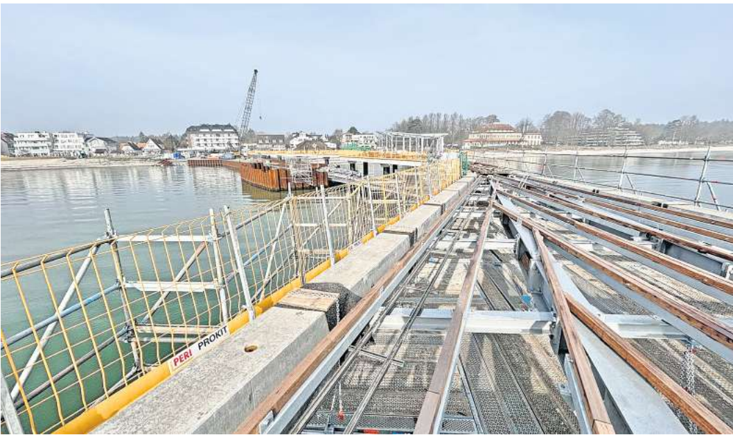
Blick von der Spitze der neuen Haffkruger Seebrücke: Das Oberdeck steht bereits, doch noch fehlt der Holzbelag. Auf dem „Knick“ in der Mitte ragt das Ständerwerk für den Wetterschutz empor. Foto: SAJ
