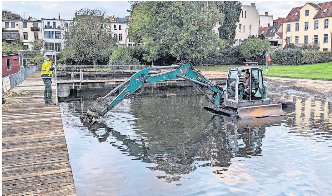
Mit einem Bagger wird Sand aus dem Freibad am Lübecker Krähenteich geschaufelt. Foto: Arno Popert/ hfr
