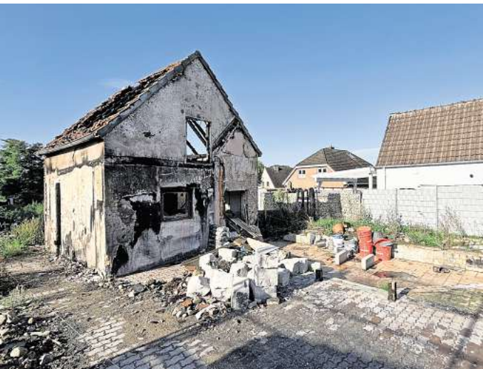
Spuren der Brandnacht sind bis heute zu sehen. Auf dem Nachbargrundstück steht diese Ruine.
