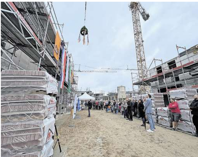
Richtfest am Hans-Kohlmorgen-Ring in Stockelsdorf. Dort entstehen 42 Genossenschaftswohnungen.
