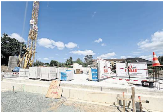
Auf dem Grundstück an der Schwartauer Straße hat sich bereits viel getan. Das ist die Betonsohle für den Sozialtrakt des Feuerwehrhauses. Fotos: Sabine Jung
