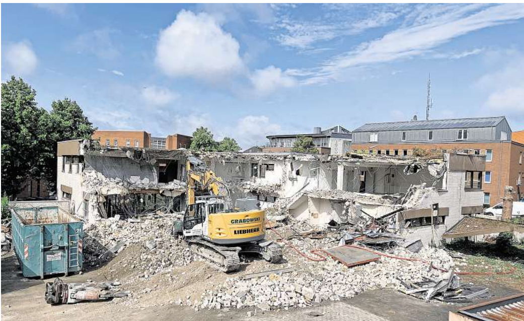
Das Abbruch-Team der Firma Grabowski macht die ehemalige Post an der Ecke Eutiner Ring/Rensefelder Straße in Bad Schwartau dem Erdboden gleich. Foto: Sebastian Prey
