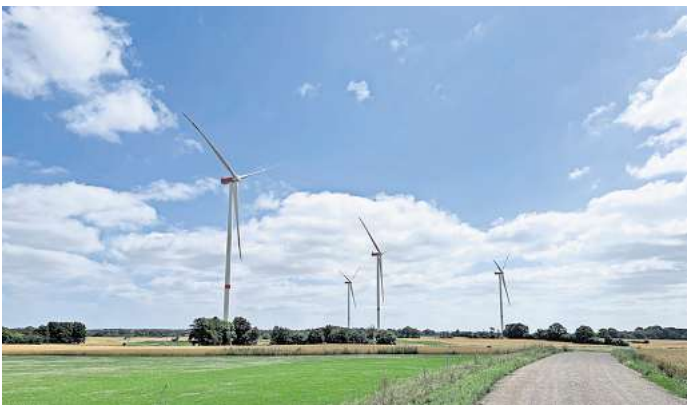
Vier Windkraftanlagen wurden auf einer 30 Hektar großen, landwirtschaftlichen Fläche der Gemeinden Ratekau und Scharbeutz errichtet. Sie können jährlich Ökostrom für 17.400 Drei-Personen-Haushalte produzieren. Foto: Beke Zill
