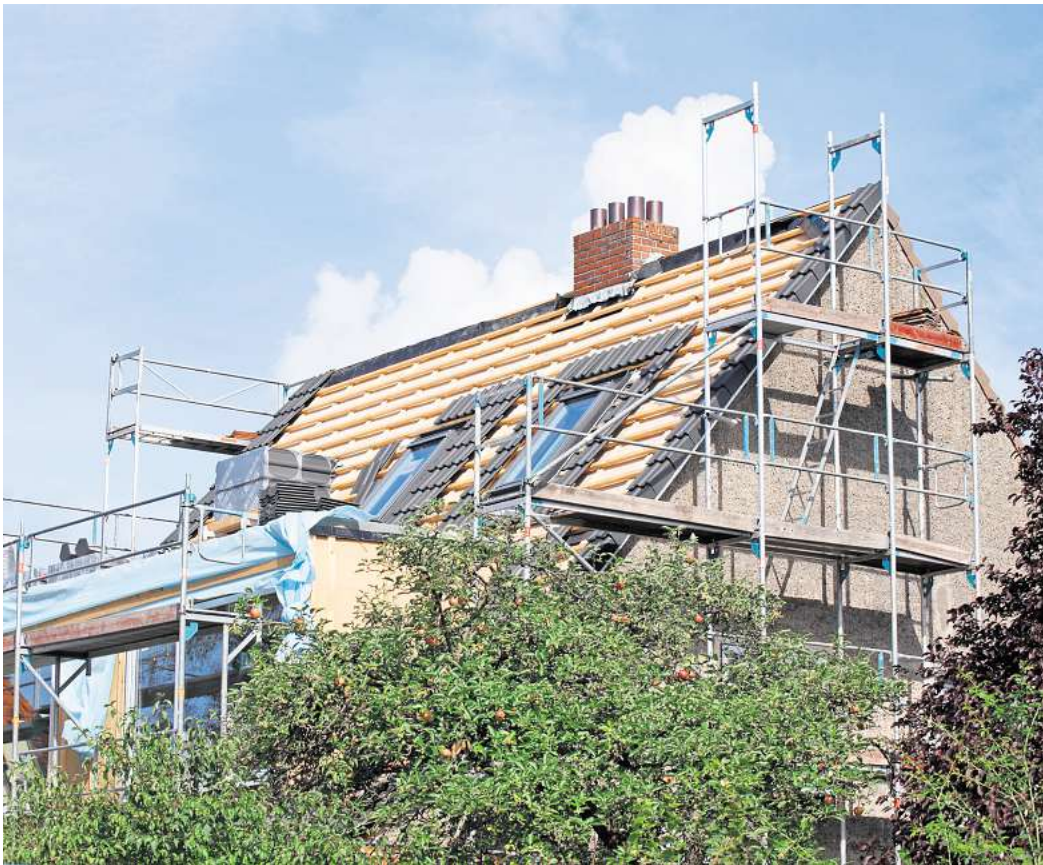
Wer bei einer Dachsanierung klug vorgeht, hat hinterher viel Freude an seinem Haus. Fotos: detailfoto, Attasit / stock.adobe.com
