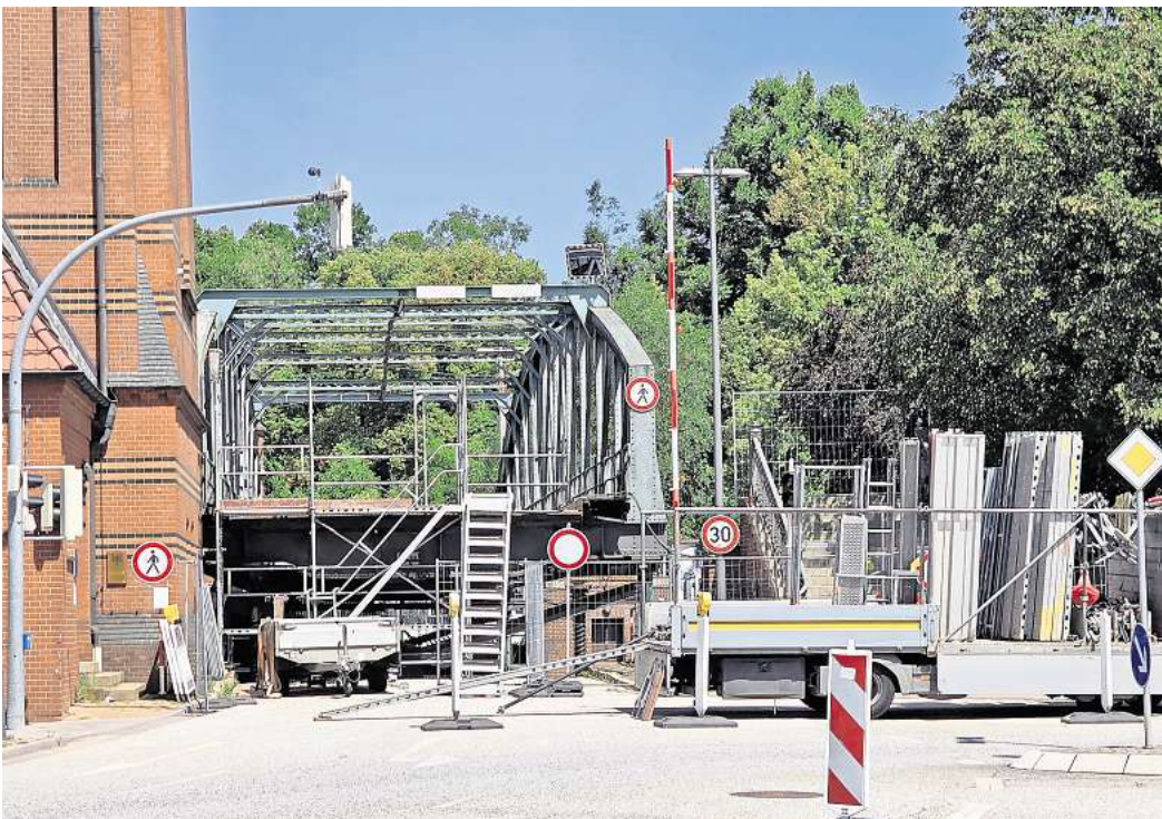
Es passiert etwas an der Lübecker Hubbrücke: Es laufen erste Arbeiten, damit die Brückenteile ausgehängt werden können.
