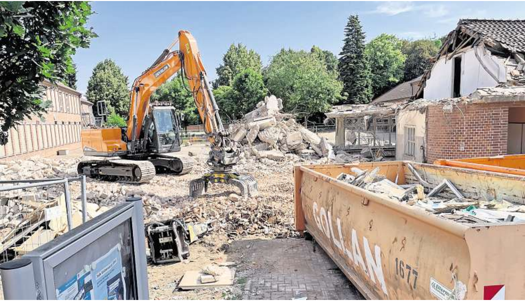
Der Abbruch des Mitteltraktes an der Grundschule Cleverbrück in Bad Schwartau ist fast abgeschlossen. Der Neubau hat eine Nutzfläche von 1100 Quadratmetern. Foto: Sebastian Prey
