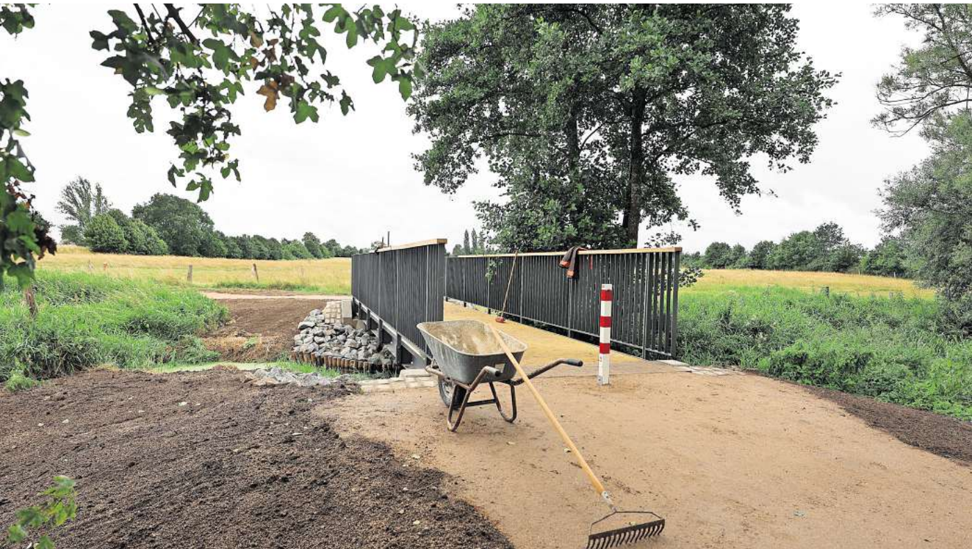
Die neue Brücke am Morier Hof über den Bach Landgraben ist fertig. Die alte Holzkonstruktion ist einer Stahlträgerkonstruktion gewichen. Foto: Lutz Roeßler
