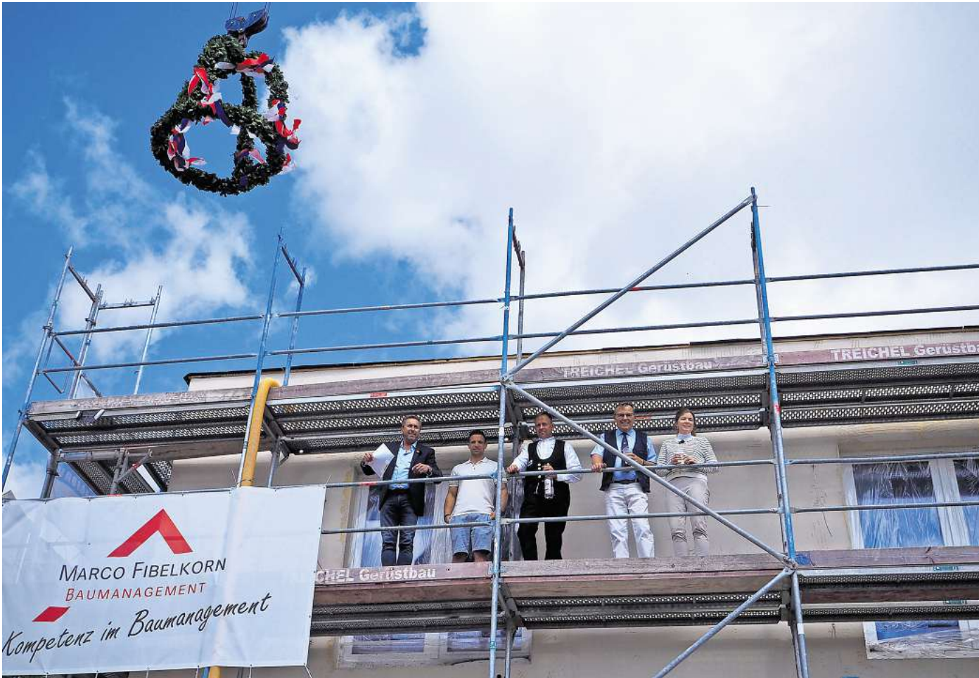
Für das Richtfest in Stockelsdorf ging es hoch aufs Baugerüst für Marco Fibelkorn (v.li.), Geschäftsführer der Baufirma Marco Fibelkorn Baumanagement, Projektleiter Jan Bohnsack, Hochbaupolier Toni Zolldann, Bürgervorsteher Manfred Beckmann und Bürgermeisterin Julia Samtleben. Foto: Hannah Detlefßen
