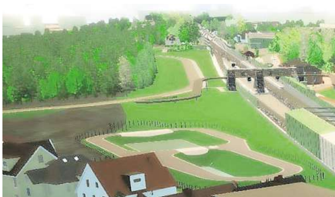
Neue Brücke an der Kaltenhöfer Straße: Die Querung fällt niedriger aus, weil die Bahntrasse in einem 3,2 Meter tiefen Trog verläuft.
