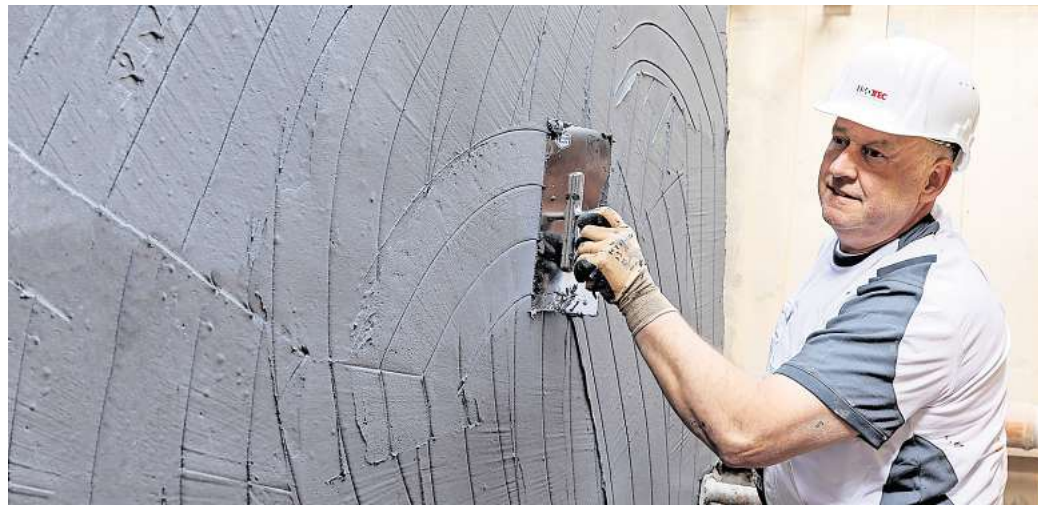
Mit einer professionellen Außenabdichtung bleibt der Keller nicht nur trocken, sondern auch vielseitig nutzbar: als Lagerraum, Homeoffice oder Hobbybereich. Foto: Isotec
