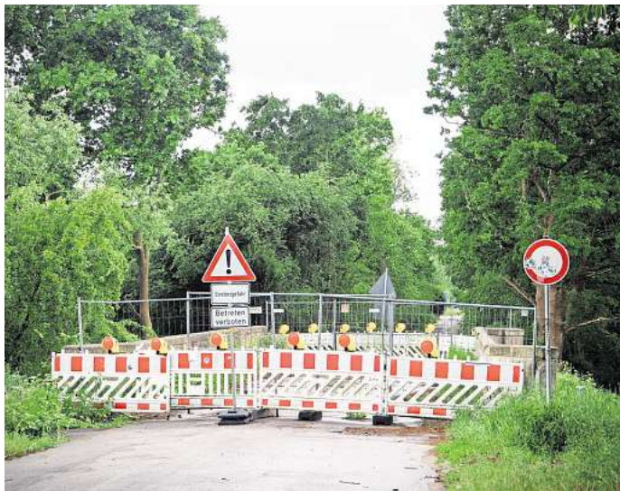
Seit Oktober 2023 ist die Brücke über die Alte Schwartau in der Kaltenhöfer Straße wegen Einsturzgefahr voll gesperrt. Foto: Hannah Detlefsen
