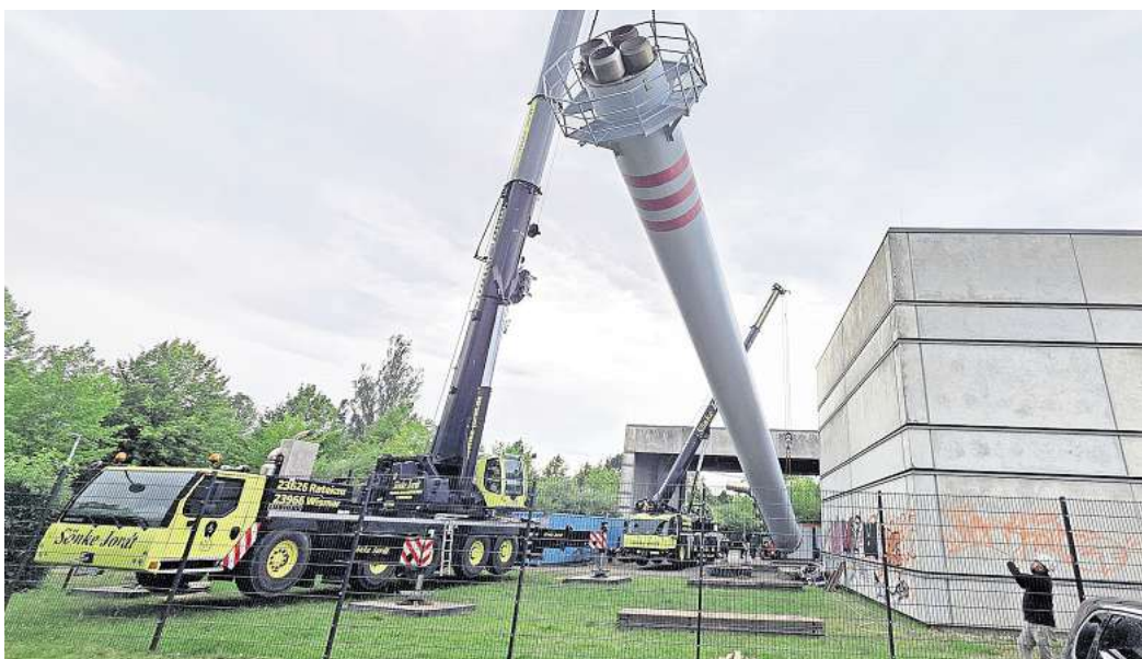
Kräne im Einsatz: Ein 23 Tonnen schwerer Schornstein an der Carl-Gauss-Straße wird aufwendig demontiert.
