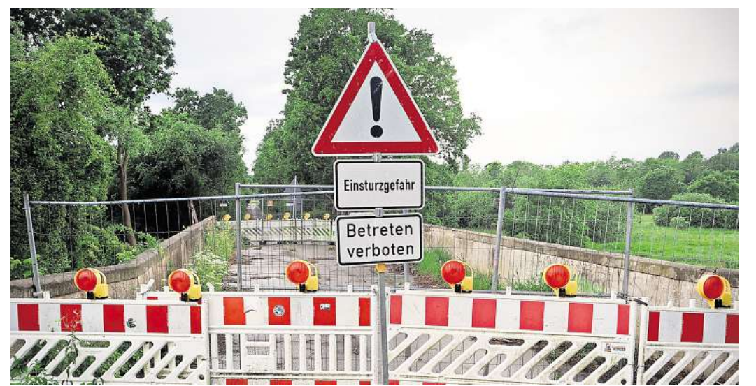
Die Brücke über die Alte Schwartau ist bis heute gesperrt. Vor fast sechs Jahren erlitt ein Radfahrer durch einen Unfall hier schwerste Verletzungen. Foto: Hannah Detlefsen
