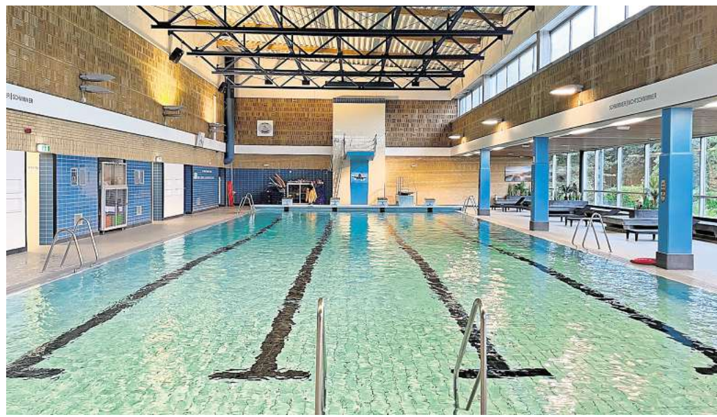
Blick in das Hallenbad in der Ludwig-Jahn-Straße. Das Becken wird häufig fürs Schulschwimmen und von Vereinen genutzt. Fotos: Sebastian Prey
