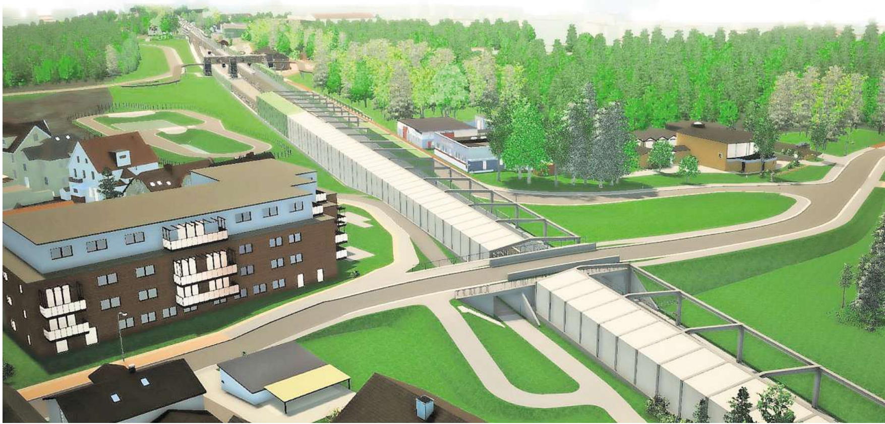
Neue Brücke an der Kaltenhöfer Straße: Die Querung fällt niedriger aus, weil die Bahntrasse in einem 3,2 Meter tiefen Trog verläuft.
