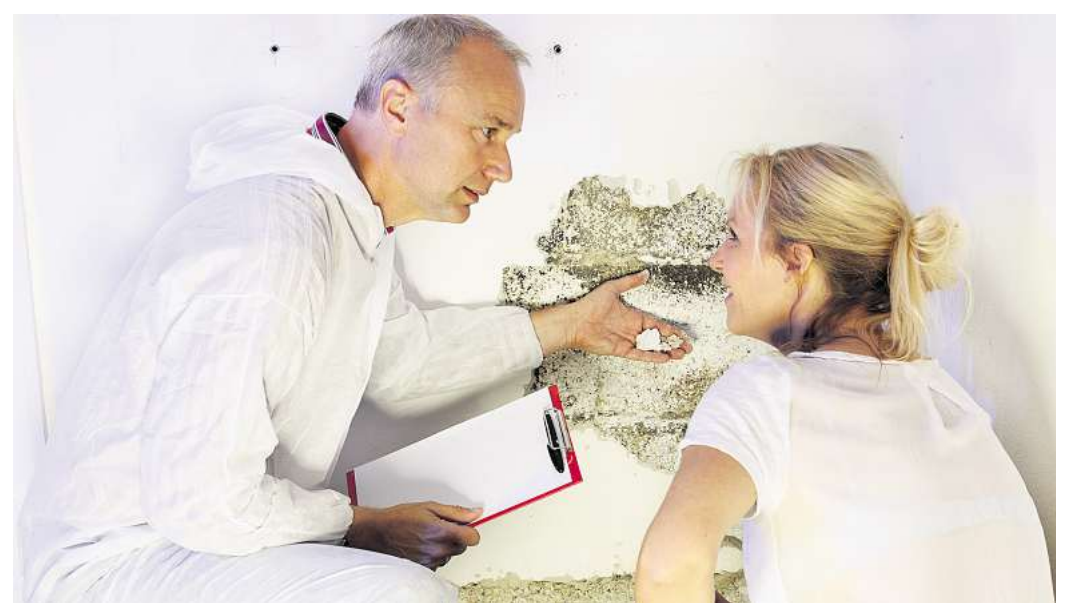
Fachleute empfehlen, die Ursache feuchter Wände und Schimmelbildung fachlich genau zu bestimmen, bevor Maßnahmen ergriffen werden. Foto: Karin/Uwe Annas, RioPatuca Images/stock.adobe.com
