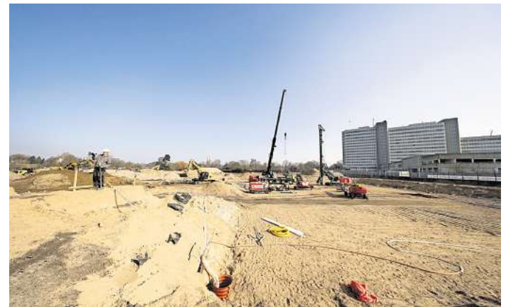
In den Boden werden sogenannte CMC-Säulen (Controlled Modulus Columns) gesetzt. Das sind Betonsäulen, die die Tragfähigkeit verbessern sollen. Fotos: Lutz Roessler
