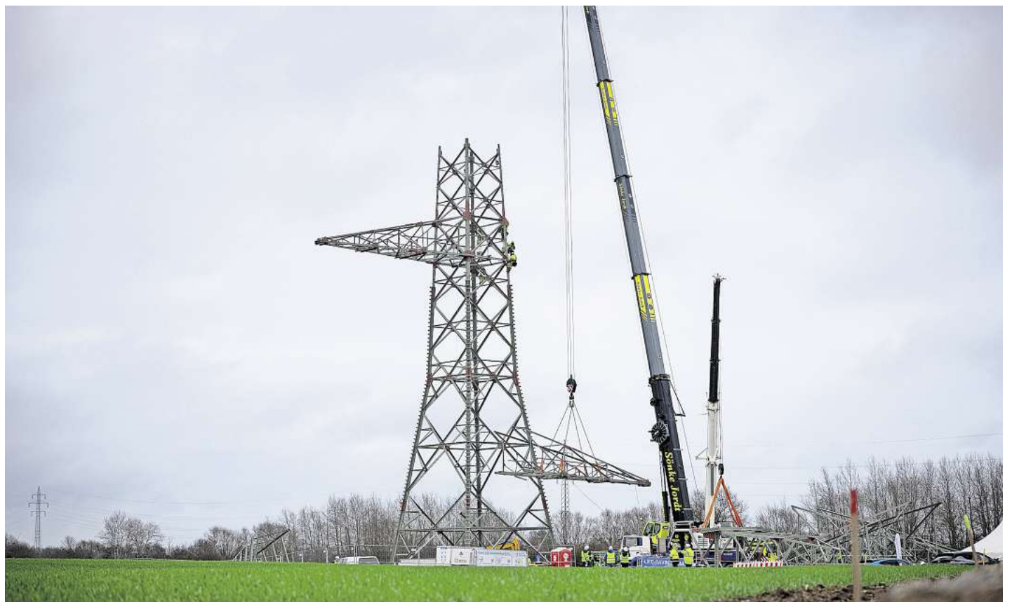
Die Masten der insgesamt 120 Kilometer langen Ostküstenleitung werden nach und nach aufgestockt. Mit riesigen Schrauben und Muttern werden die Traversen befestigt.
