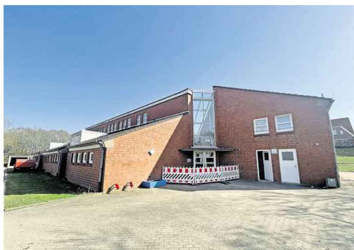
Ansicht von der Sportplatzseite: Seit Anfang Dezember wird der Umkleidetrakt des Sportzentrums Jahnstraße in Stockelsdorf umfassend saniert.
