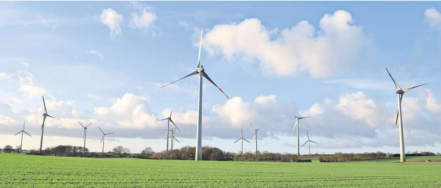
Wenn es nach dem Betreiber Qualitas Energy geht, sollen die Windräder in der Gemeinde Stockelsdorf durch größere Anlagen ersetzt werden. Foto: Gemeinde Stockelsdorf
