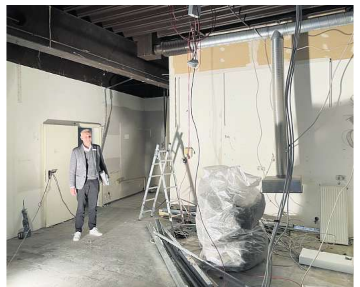
Die Bauarbeiten sind gestartet: In der Twiete in Bad Schwartau werden die Ladenflächen von Matzen Herzstück und Matzen Spezial um eine Ladenfläche erweitert und verbunden.
