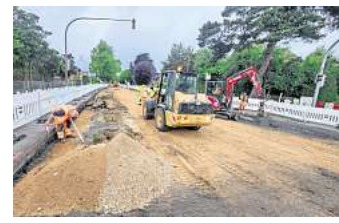
Dauerbaustelle: In diesem Jahr wurde die Moislinger Allee grundsaniiert. Foto: Holger Kröger
