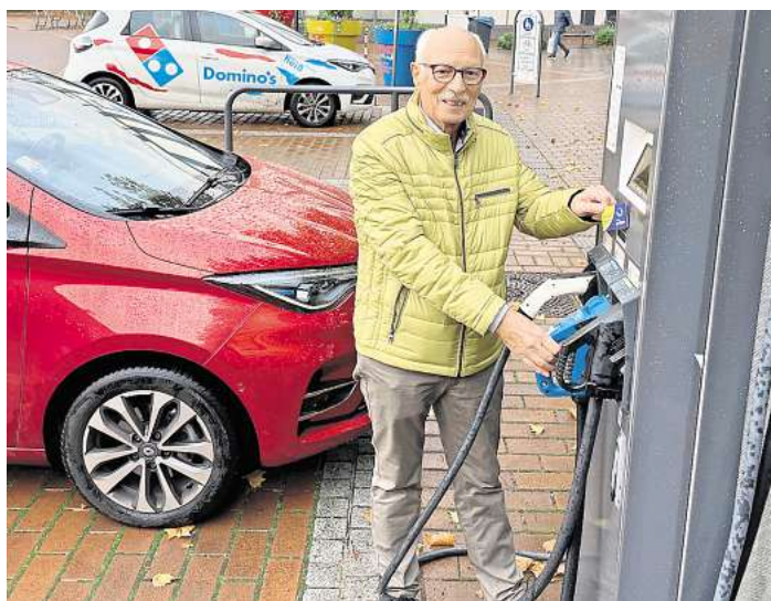
Prof. Peter von Viebahn ist ein Verfechter der E-Mobilität: „Wichtig ist auch, dass die Ladepunkte funktionieren. Die Ladesäule am Zentralparkplatz ist nun schon seit Wochen defekt.“ Fotos: Sebastian Prey
