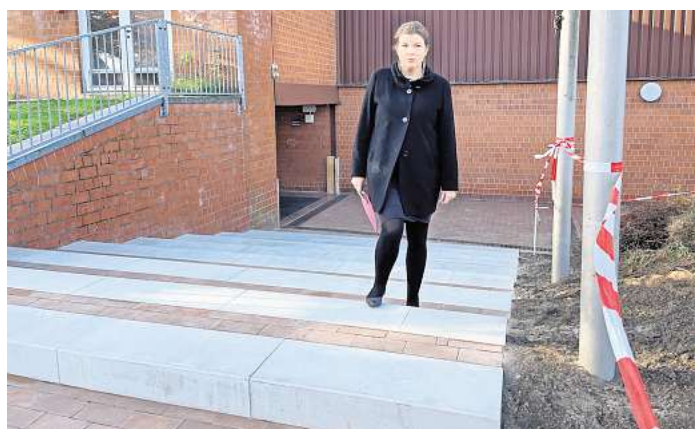
Stockelsdorfs Bürgermeisterin Julia Samtleben (SPD) an der neuen Treppenanlage zur Großsporthalle am Rensefelder Weg. „Die Treppe soll verhindern, dass bei Starkregen das Wasser vom Parkplatz in Richtung Halle abläuft.“
