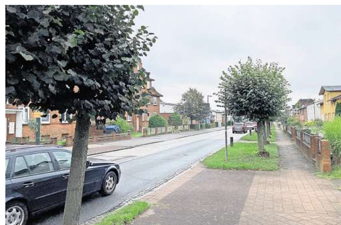
Dieser Radweg am Tremskamp in Bad Schwartau soll bis zur Einmündung Rudolf-Carsten-Straße verlängert werden. Fotos: S. Prey
