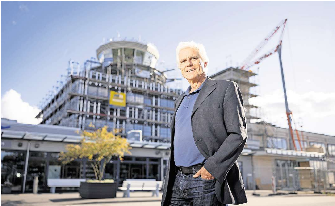
Neubau am Flughafen: Geschäftsführer Jürgen Friedel steht vor dem Gebäude, in das Tower, Restaurant und Kongresszentrum einziehen sollen.
