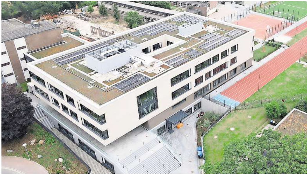
Das Küstengymnasium in Neustadt ist weitgehend saniert. Im dritten Abschnitt soll der Sporthallenkomplex erneuert werden. Dafür käme Fördergeld vom Bund sehr gelegen. Foto: Stadt Neustadt
