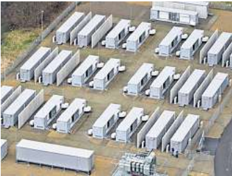
So sehen Batteriespeicher aus. Diese Anlage steht im brandenburgischen Spremberg und ist mit einer Leistung von 53 MW relativ klein. Foto: P. pleul
