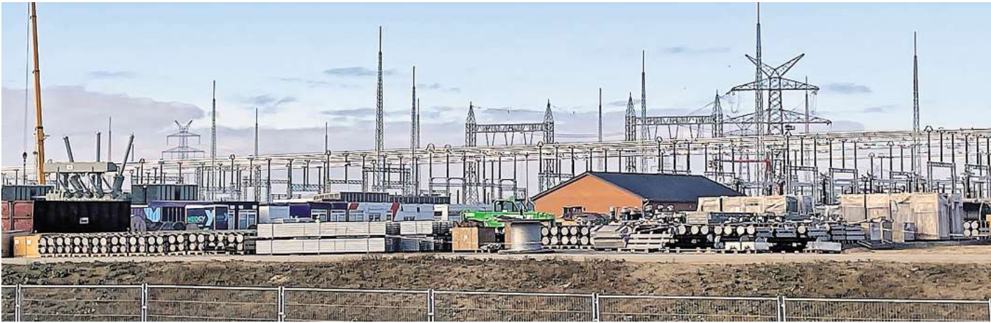
Großbaustelle bei Pohnsdorf: Ein neues Umspannwerk wird derzeit in Stockelsdorf direkt an der L184 errichtet. Es trägt den Namen Lübeck-West. Von dort geht die Ostküstenleitung weiter gen Henstedt-Ulzburg. Auch die Elbe-Lübeck-Leitung, die durch Stormarn führt und nach Geesthacht geht, wird dort mit angebunden.
