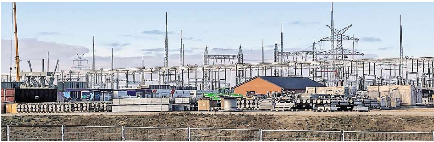
Großbaustelle bei Pohnsdorf: Ein neues Umspannwerk wird derzeit in Stockelsdorf direkt an der L184 errichtet. Es trägt den Namen Lübeck-West. Von dort geht die Ostküstenleitung weiter gen Henstedt-Ulzburg. Auch die Elbe-Lübeck-Leitung, die durch Stormarn führt und nach Geesthacht geht, wird dort mit angebunden. Foto: Sebastian Prey
