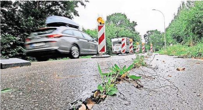
Ein Bild aus dem Oktober 2023: Unkraut hat sich in den Rissen im Asphalt der B432 breit gemacht.
