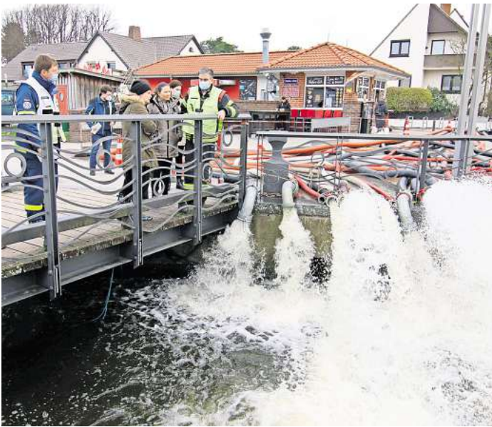
Pumpeinsatz des Technischen Hilfswerks in Niendorf: Mit der Leistung von 45.000 Litern pro Minute wird versucht, die überschwemmte Aalbek-Siedlung trocken zu legen.
