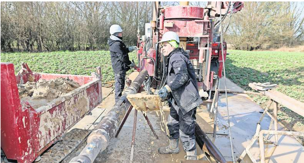
Bohruntersuchungen für die neue Bahntrasse bei Ratekau. Khairollah Sharifi (r.) und Axel Ziemke holen das Erdreich mit der Rohrdrehanlage ans Tageslicht. Foto: Lutz Roeßler
